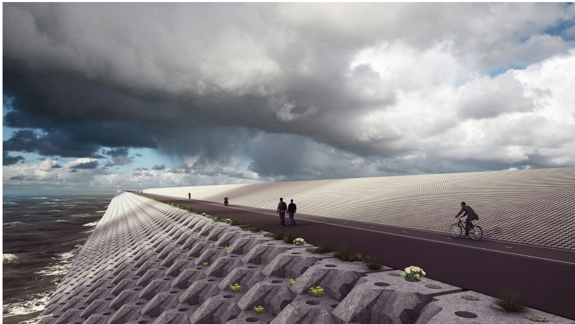
AFBEELDING 5.12 LEVVEL BLOCKS AFSLUITDIJK. BRON: WATERFORUM 65
