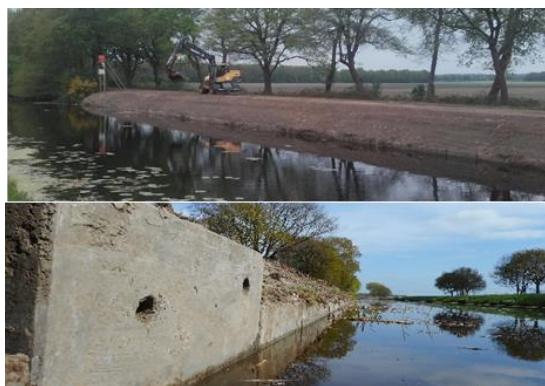
Figuur A-2 Voorbeeld van oeverblokken in het oranjekanaal
